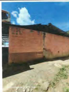
Foto 2: REPARACIÓN DE PARED DE COCINA
