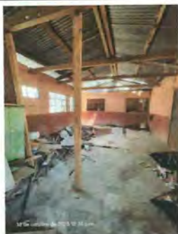
Foto 3: SUSTITUCIÓN DE PISO DE CONCRETO POR PISO CERÁMICO
